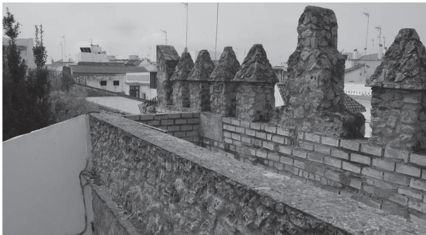
Fig. 9. Vista de la parte superior del Arco de Rota donde se puede ver la fábrica de ladrillos perforados y el revestimiento externo de piedras que simula y falsea como si se tratase de una obra de mampostería. Foto: Juan M. Piñero
