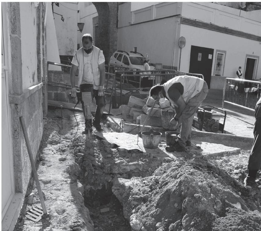
Fig. 4. Inicio de los trabajos de apertura de zanjas en la parte norte de la plaza. Foto: Juan M. Piñero
