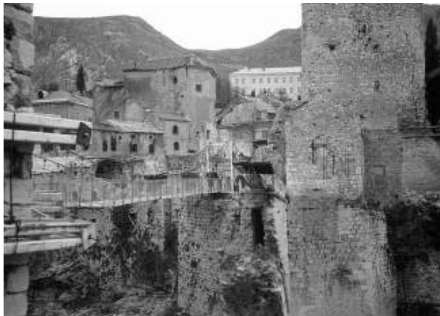
Fig. 4. El puente de Mostar tras su destrucción
