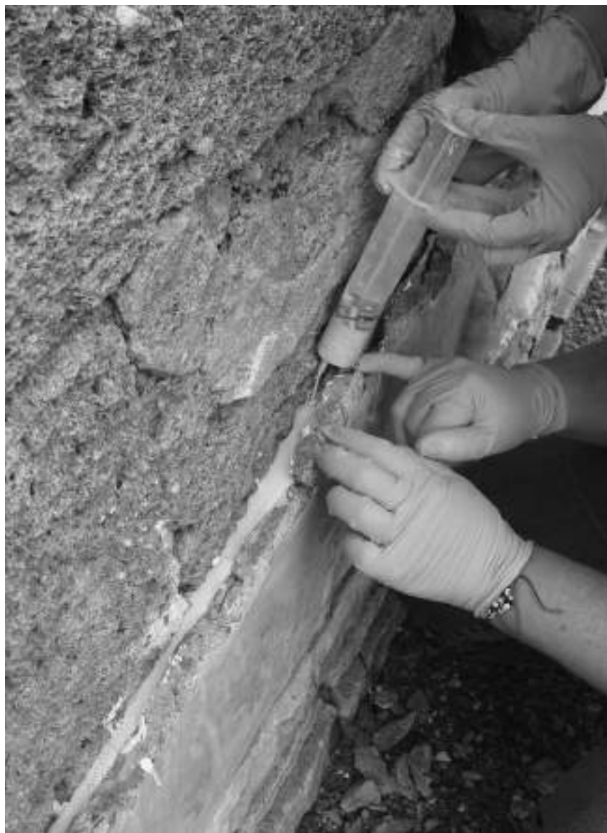
Fig. 3. Consolidación de revestimientos separados del soporte mural. Conjunto Arqueológico de Baelo Claudia . Foto Iván García.
