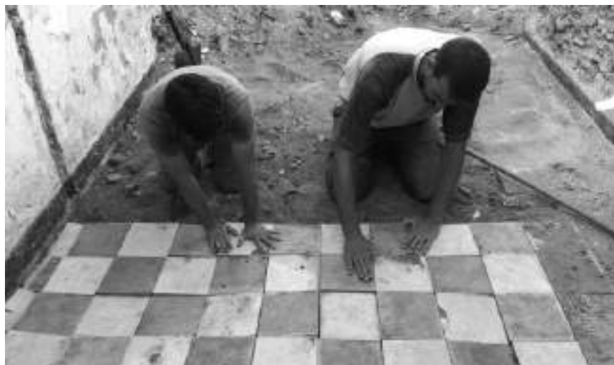
Fig. 11. Reposición de parte de la solería donde se realizó el sondeo 2
