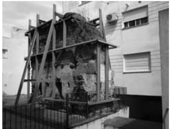
FIGURA 3 Torre del Cabildillo. Posible resto de la muralla del hishn islámico, del cerco de muralla de la Sanlúcar musulmana. (¿siglos XI-XII?)
